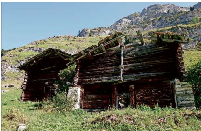
Auch die fachgerechte Renovation dieser Doppelställe stellt grosse Anforderungen an die Stiftung Avers Ställe.
